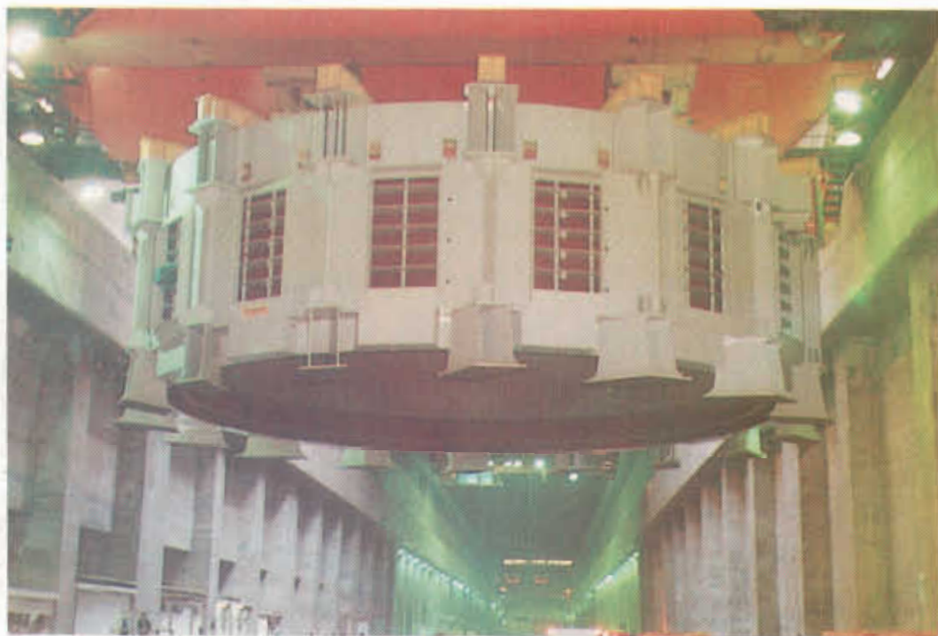
Descenso del estator de la unidad generadora n° 12 (60 Hertz) - realizado el 17.08.87.
