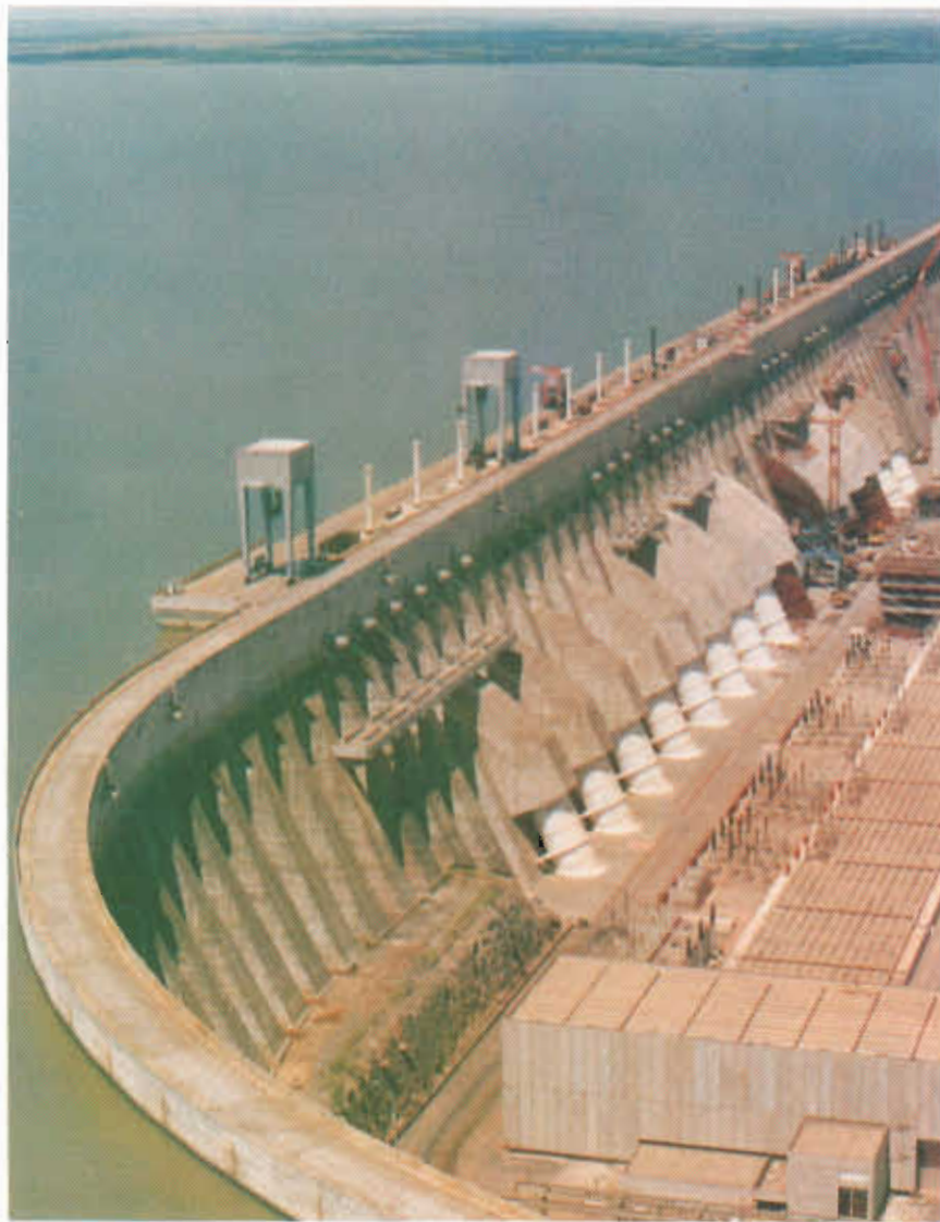
La Central Hidroeléctrica de Itaipú. En operación, nueve unidades generadoras, o sea, 50% del total previsto para la casa de máquinas. En diversas etapas de montaje, ocho máquinas, con previsión de término en el trienio 1988/89/90.
