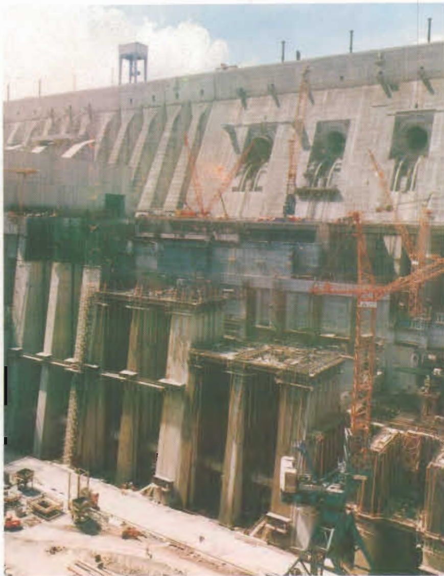
Situación del bormigonado de la casa de máquinas de la central hidroeléctrica de Itaipú, en el trecho del antiguo canal de desvío - unidades generadoras n°s 16, 17 y 18, todas de 60 Hertz.
