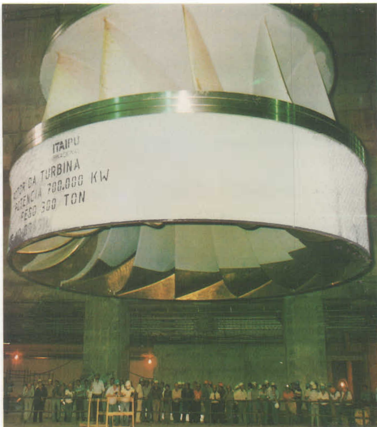
Descenso del rotor de la turbina hidráulica de la unidad generadora n.º 9 (50 Hertz) - realizado el 23.04.87.
