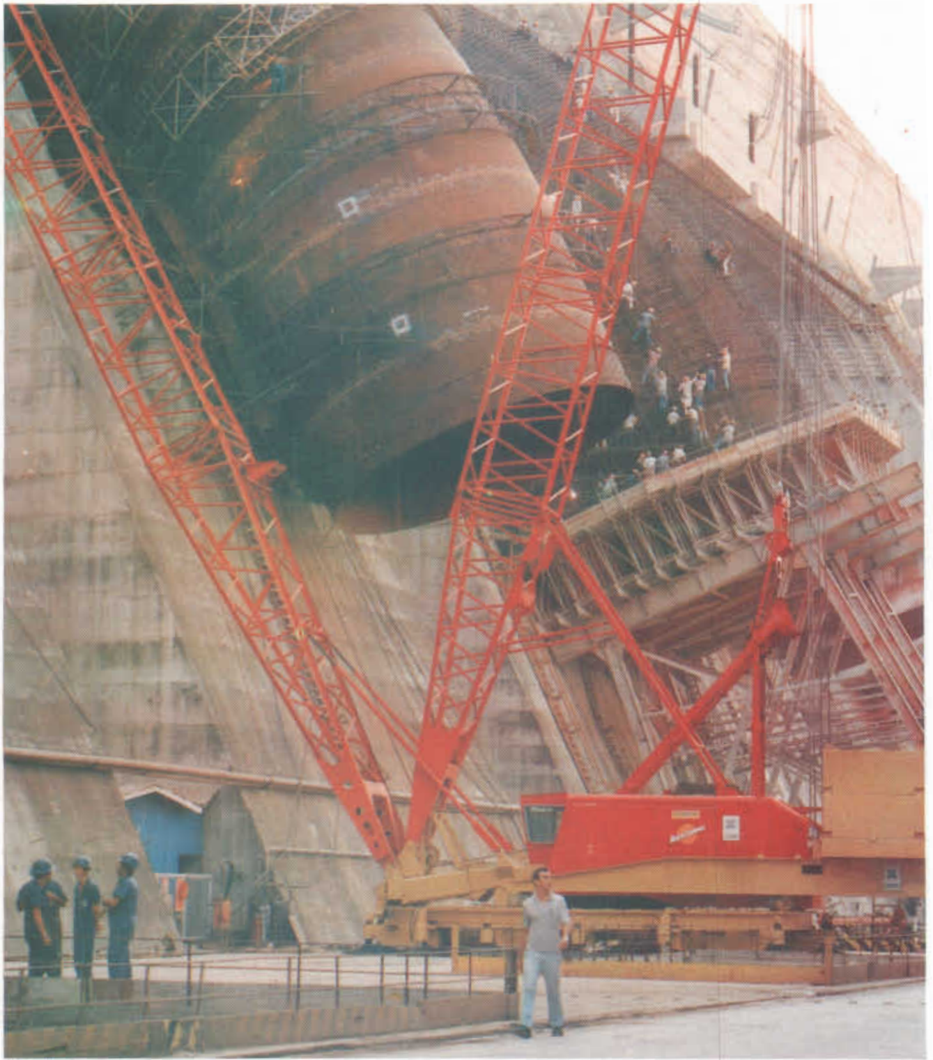
Trabajos de instalación de una de las tuberías de presión, en 1987.
