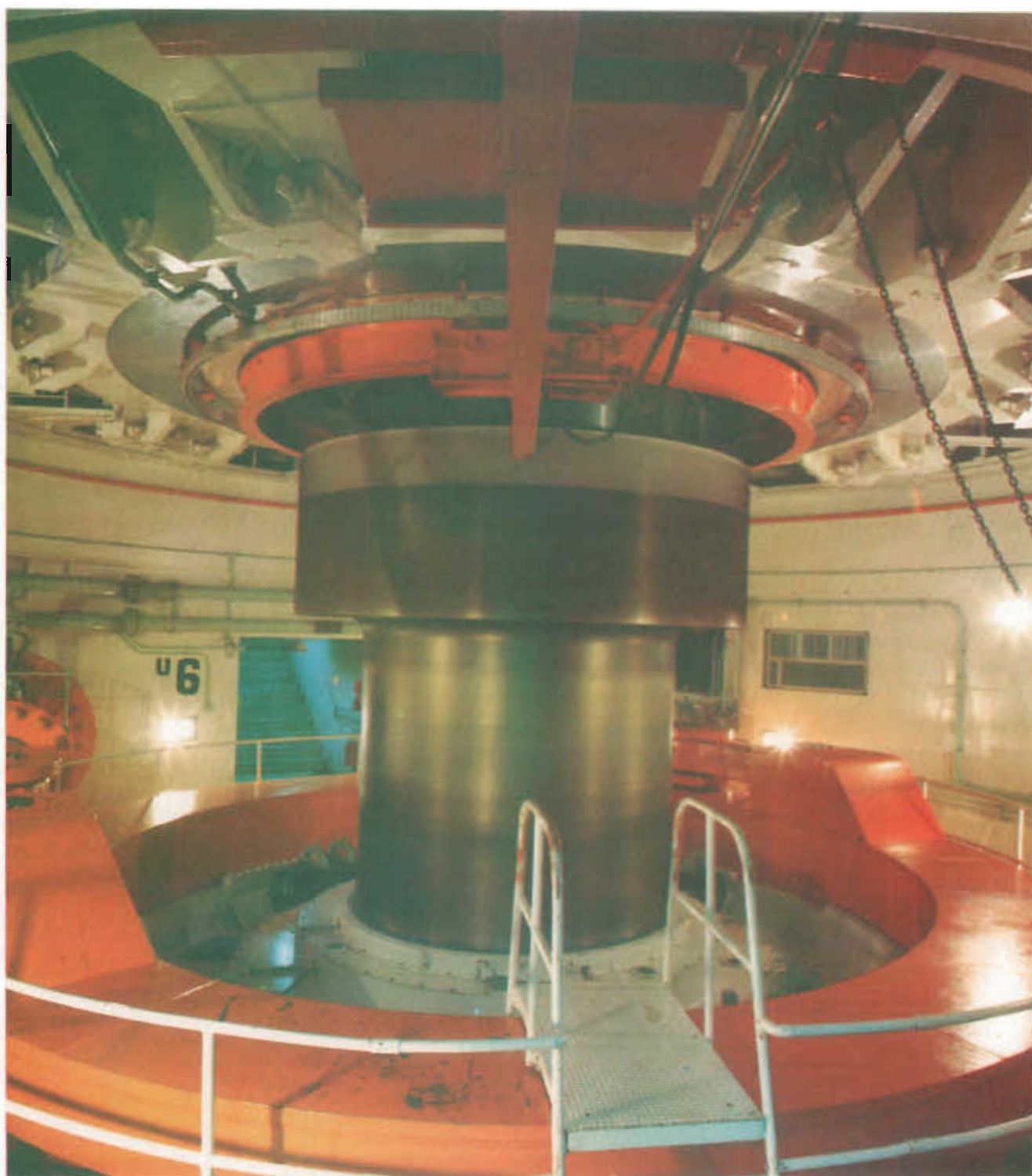
1er Giro mecánico de la unidad generadora n° 6 (50 Hertz) realizado el 26.06.87.
