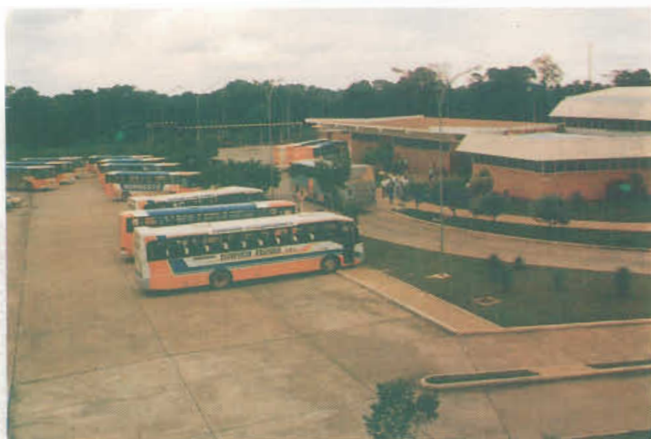
Centro de Recepción de Visitas, en la margen derecha, idéntico al existente en la margen izquierda, donde son recibidos grupos interesados en conocer Itaipú.
