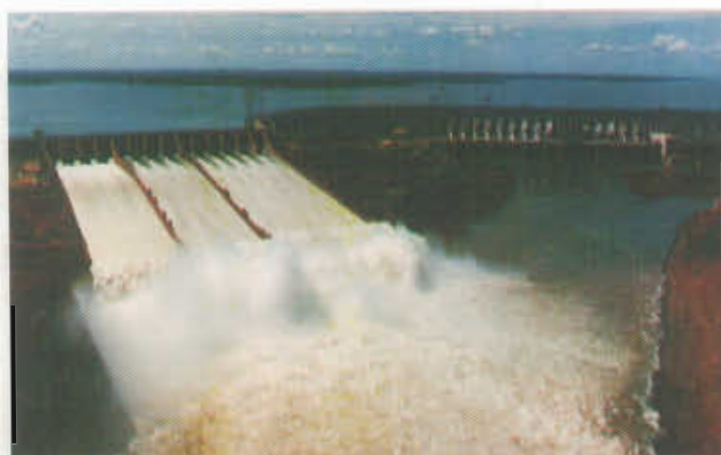
Foto de la tapa: visión de conjunto de la Central Hidroeléctrica de Itaipú.
